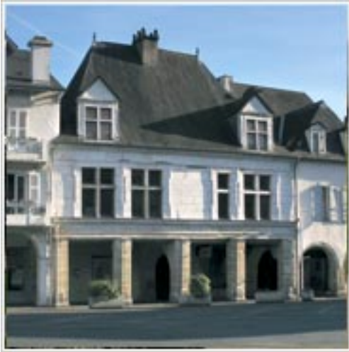
La Maison Carrée
